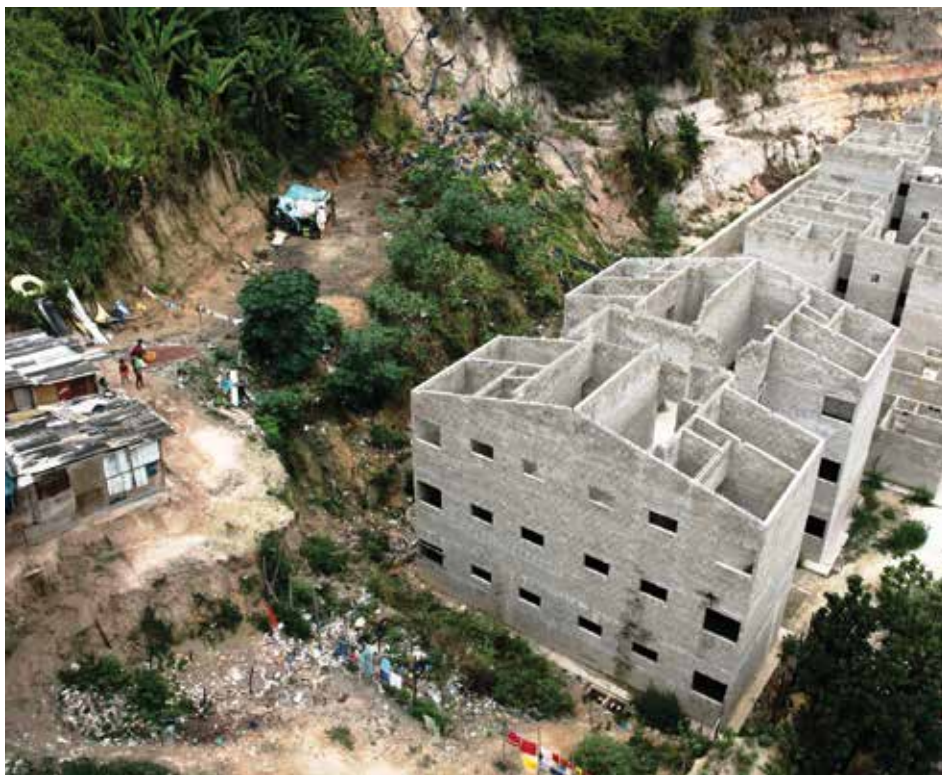
Ocupação de sopé de taludes de acentuada declividade – Maceió – AL. Foto cedida por M. Carnáuba
