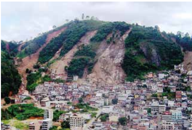
Idem. Com ocupações de sopé descalçando as encostas. Nova Friburgo – RJ. Foto: Heleno da Costa Miranda
