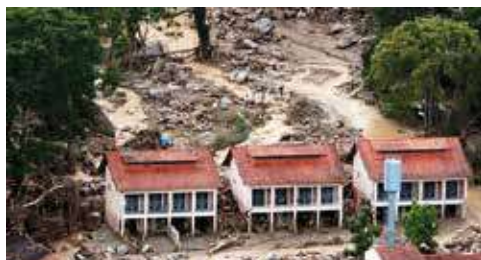
Ocupação de áreas de topografia suave, mas sujeitas geologicamente a passagens de corridas de detritos. Teresópolis – RJ
