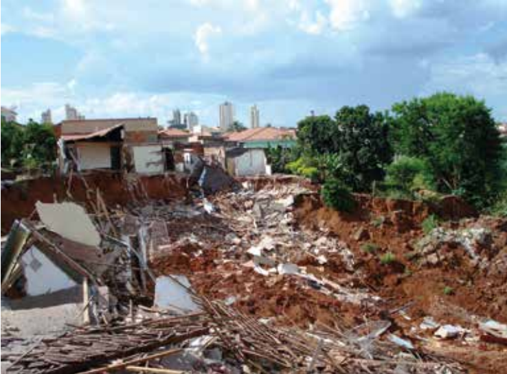
Ocupação urbana de cabeceira de antiga bossoroca é destruída por propiciar a reativação dos processos erosivos. Campo Alto (SP). Foto: G. Salviano
