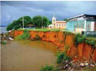
Terras caídas. Porto Velho – RO
