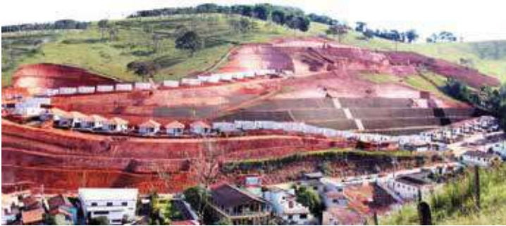
Projeto urbanístico público. O mesmo erro técnico de concepção urbanística e construtiva se repetindo em ocupações irregulares e em ocupações regulares e institucionais
