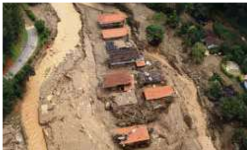
Moradias instaladas em áreas baixas de vales historicamente sujeitos à passagem de corrida de detritos. Região Serrana – RJ
