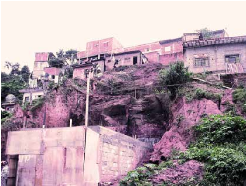
A temerária obsessão pela produção de platôs planos através de uma sucessão de cortes e aterros. São Paulo – SP. Foto: ARSantos
